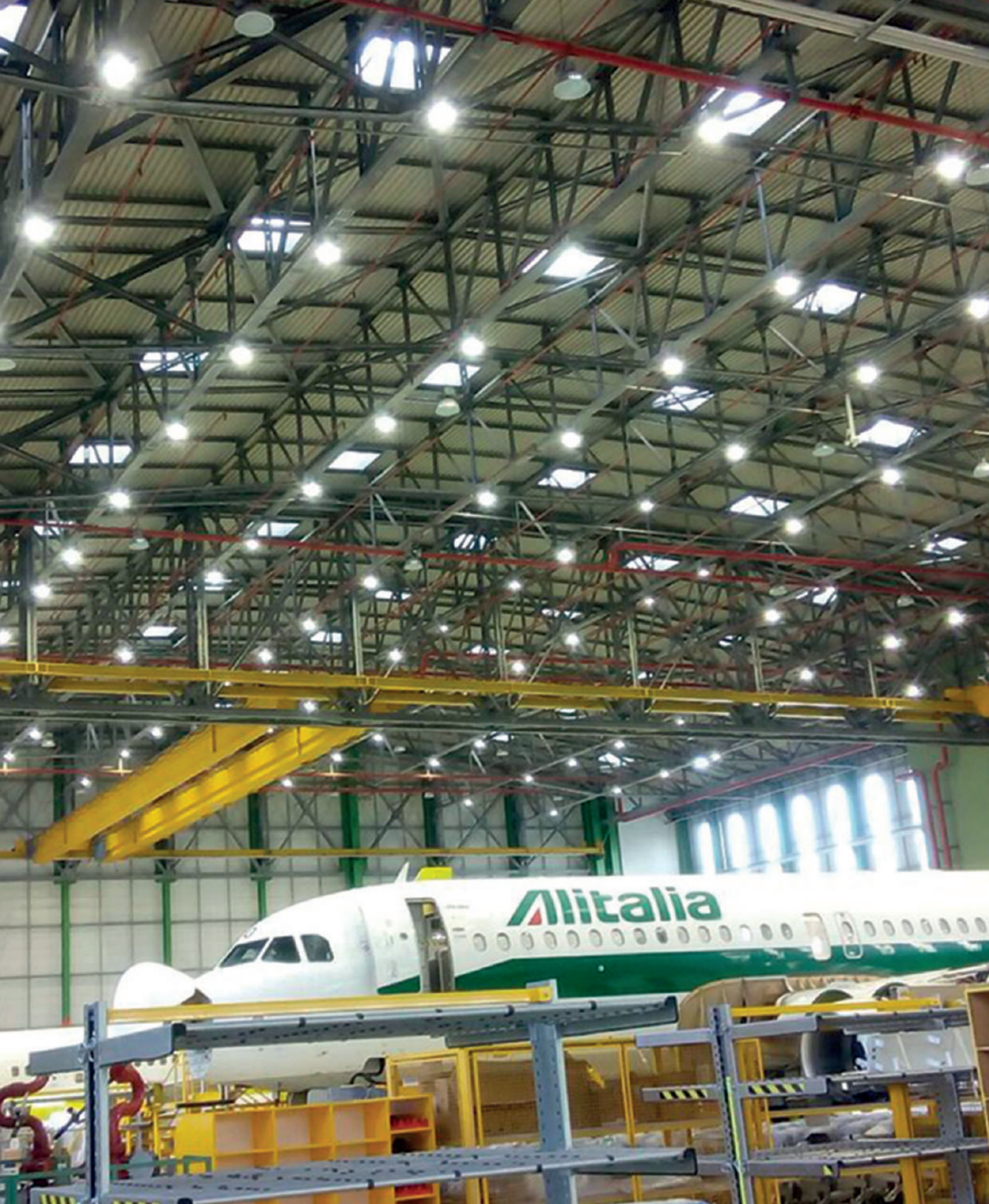
AEROPORTO DI NAPOLI - NAPLES AIRPORT - ITALY
